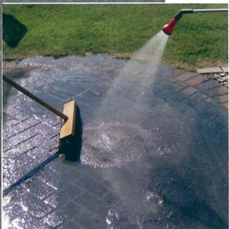
Nach dem Einschlämmen, überflüssigen feuchten Pflasterfugensand mit einem Straßenbesen abfegen.
